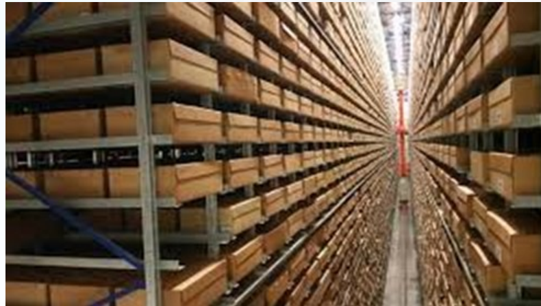
Automatische dozenopslag – multi-diep
